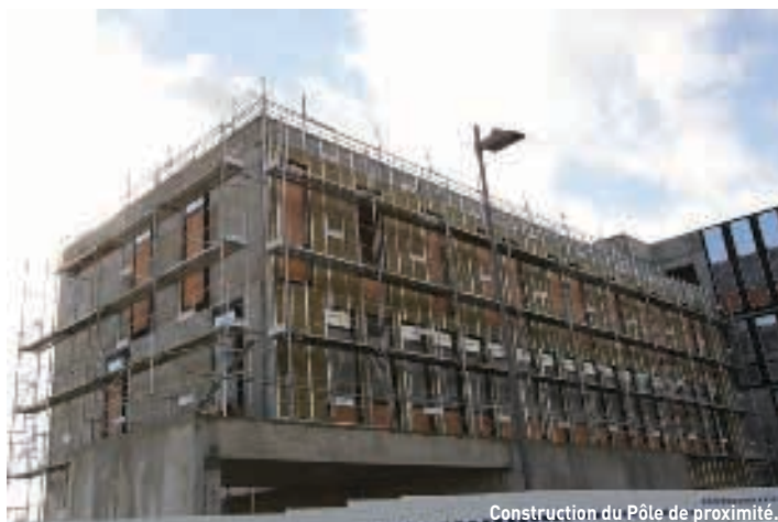
Construction du Pôle de proximité.
